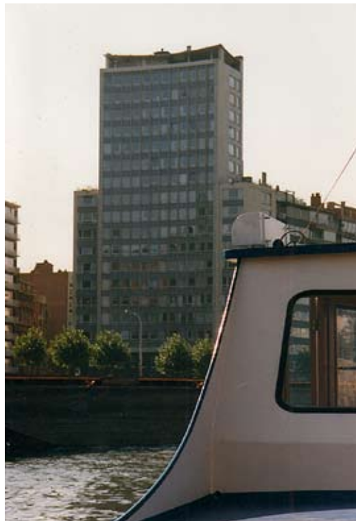
«Résidence Élysée» (1961), quai Marcellis 1 à Liège Architectes R. Dallemagne et F. De Lame © Homme et Ville, 1999
