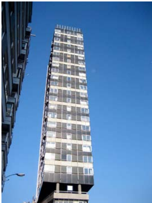
«Résidence Simenon» (1963), rue Méan à Liège Architecte J. Poskin © Homme et Ville, 2007
