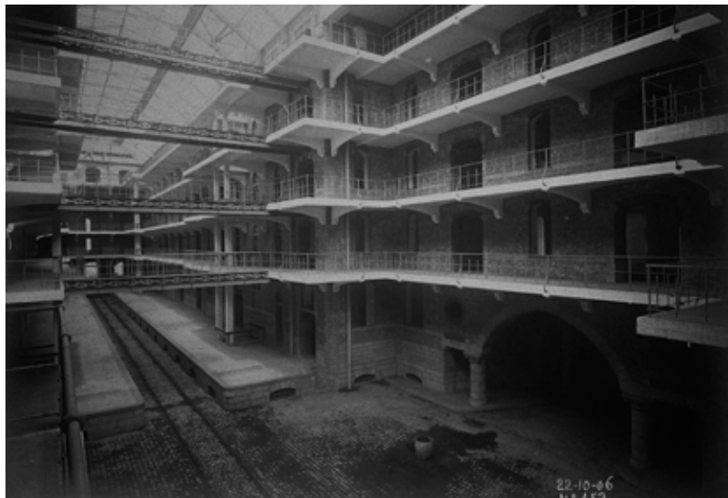
Photo Louvois de l'entrepôt à la réception du chantier en 1906 © Archives de la Ville de Bruxelles
