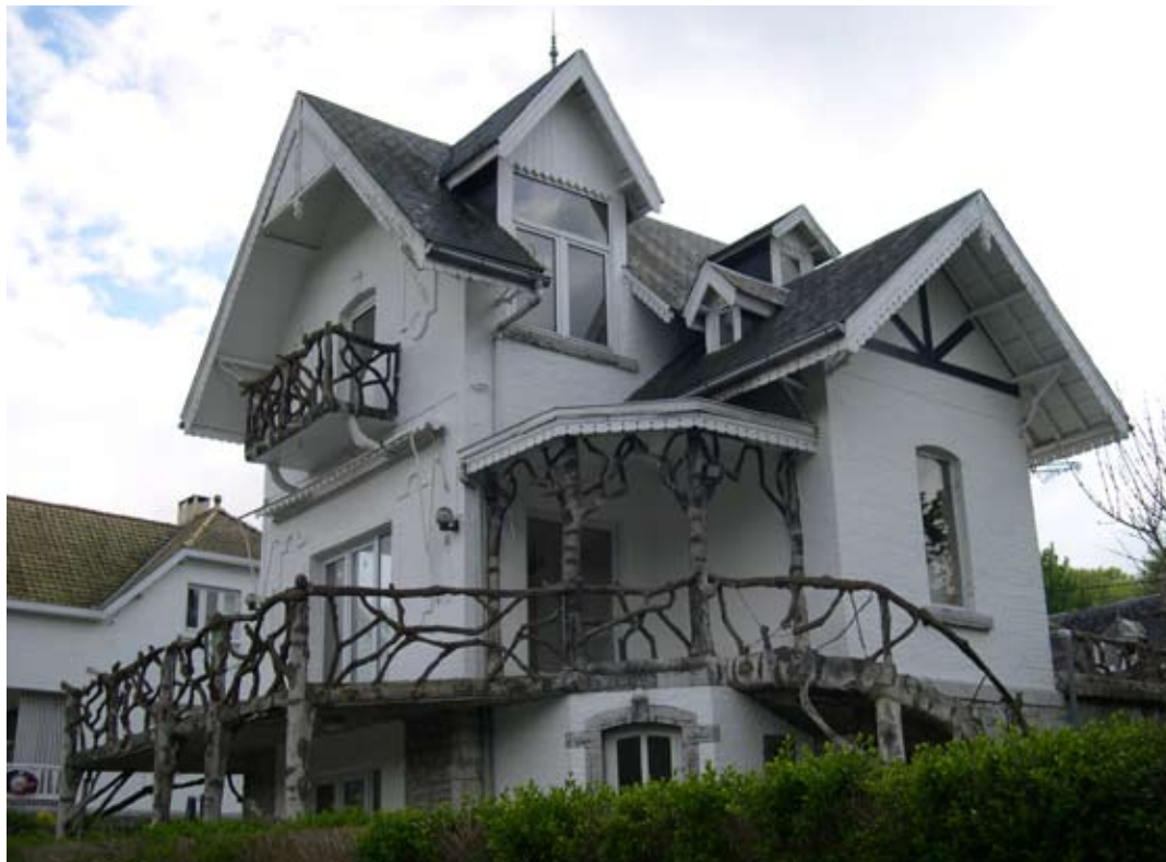
À Wépion, le photographe Armand Dandoy a vécu au bord de la Meuse dans cette villa cernée de garde-corps en ciment armé, malheureusement assez dégradés aujourd'hui et partiellement disparus. Photo E. Guillaume
