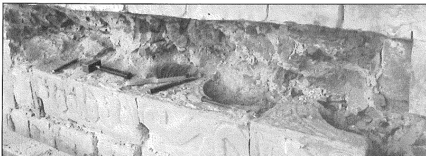
Les fonts baptismaux de la collégiale Saint-Vincent, encastrés dans le parement de la tour occidentale, en cours de dégagement.
