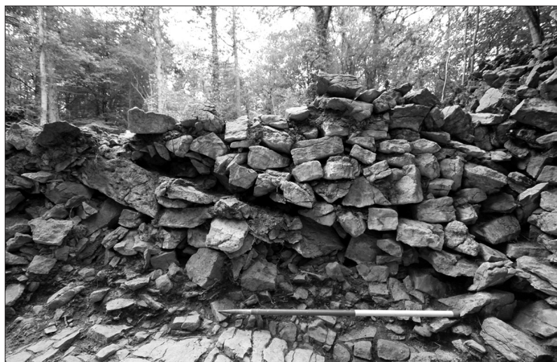
Vue du parement arrière du rempart avec sa poutraison.
