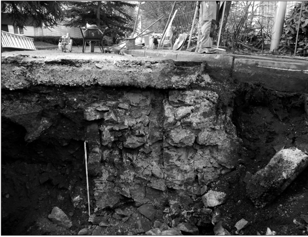
Tranchée pour le collecteur de l'avenue Batta. Coupe à travers les fondations des deux murailles accolées du rempart, parallèles à l'ancienne rue Sur les Bas Fossés.
