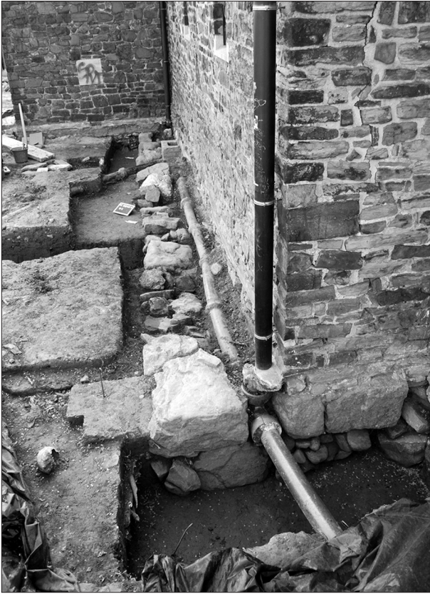
Mur arasé au pied du gouttereau nord de la chapelle.
