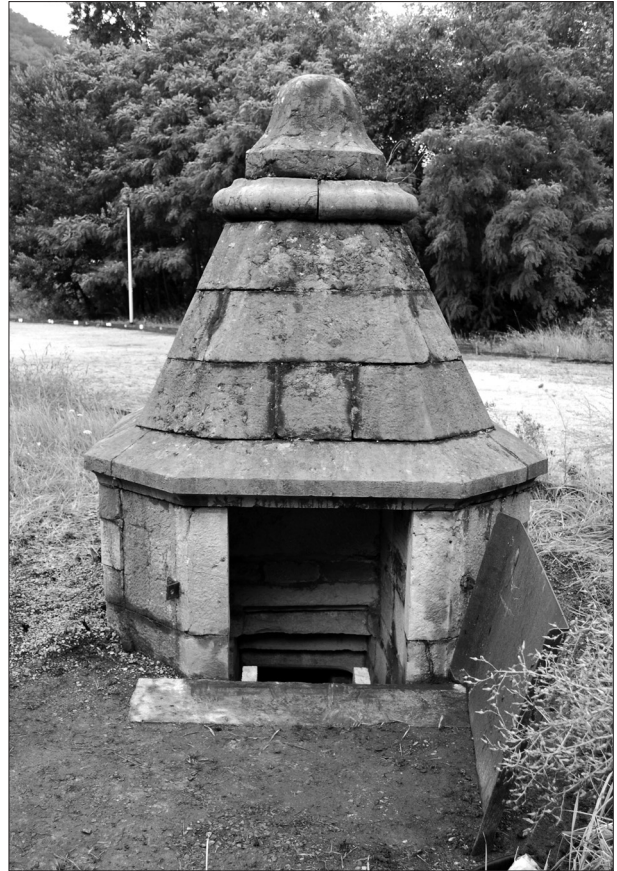
Tourelle construite sur le captage de la source du bassinia , dans le quartier Sainte-Catherine.
