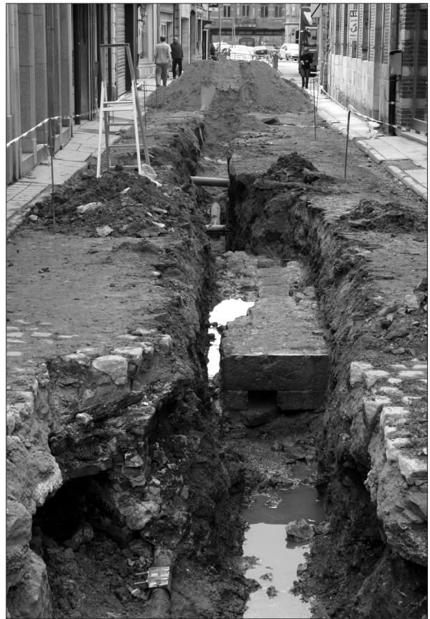
La base de la porte de Virelles, avec en son centre le canal d'évacuation des eaux de la rigole qui se trouvait autrefois au milieu de la rue Rogier.
