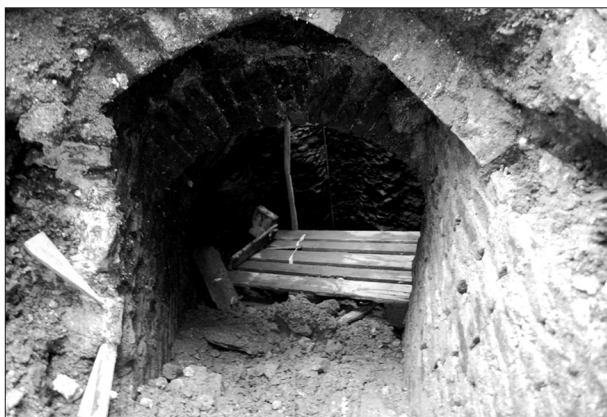
Charleroi, Îlot Dauphin : accès à la salle souterraine située sous la rue Neuve.
