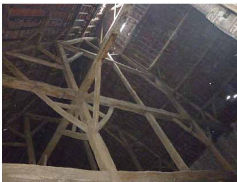
Vue des charpentes de la ferme d'Havay, Rue de l'Abreuvoir. © Elisabeth Vanachère
